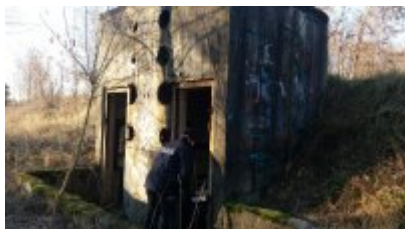
Kontrola miejsca przebywania osób narażonych na wychłodzenie
